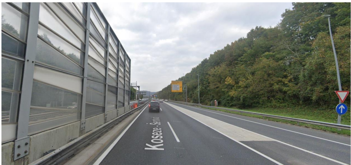
Slika 16: Pogled na mesto pojavljanja zastojev – AC-A2/0613 LJ (ŠENTVID - KOSEZE)
