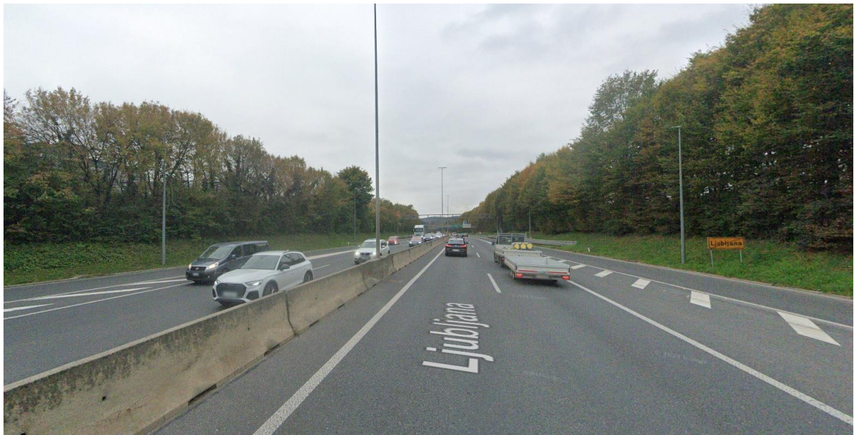
Slika 14: Pogled na mesto pojavljanja zastojev – HC-H3/0090 LJUBLJANA (CELOVŠKA – KOSEZE)
