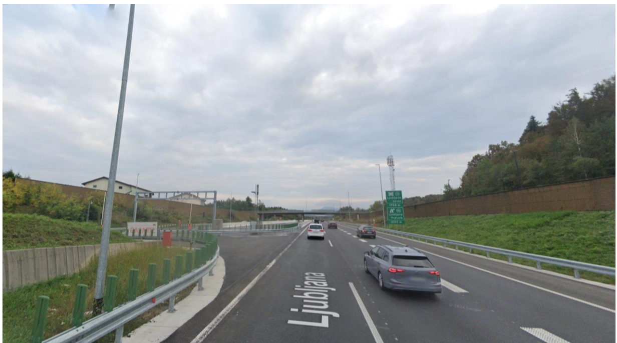
Slika 2: Pogled na mesto pojavljanja zastojev - AC-A2/0013 LJ (ŠENTVID – KOSEZE)
