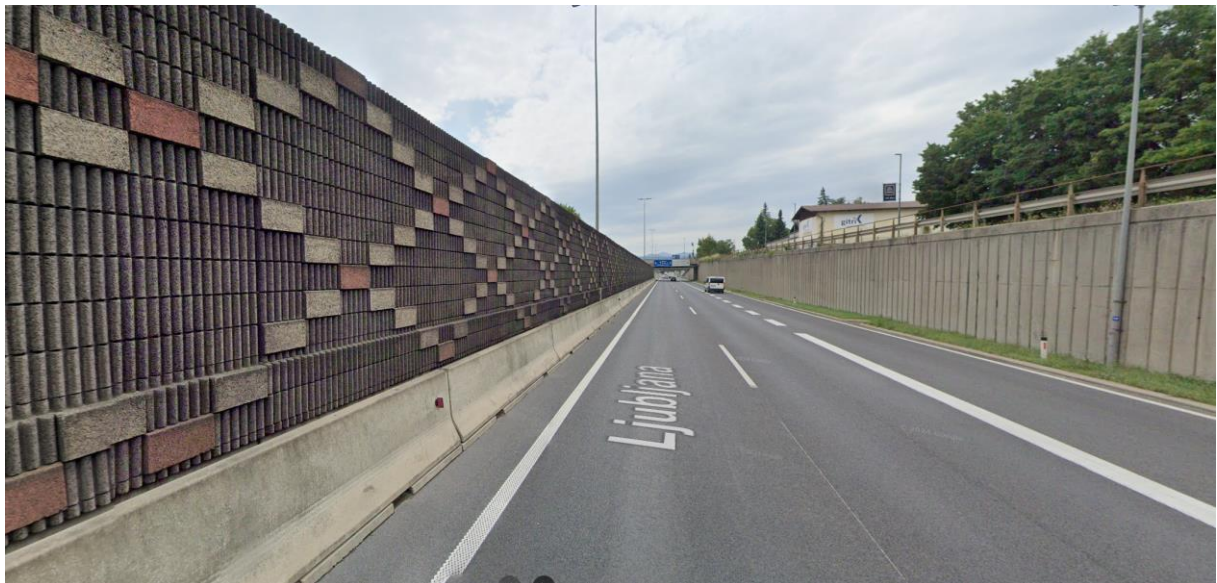
Slika 10: Pogled na mesto pojavljanja zastojev – HC-H3/0689 LJ (DUNAJSKA - CELOVŠKA CESTA)
