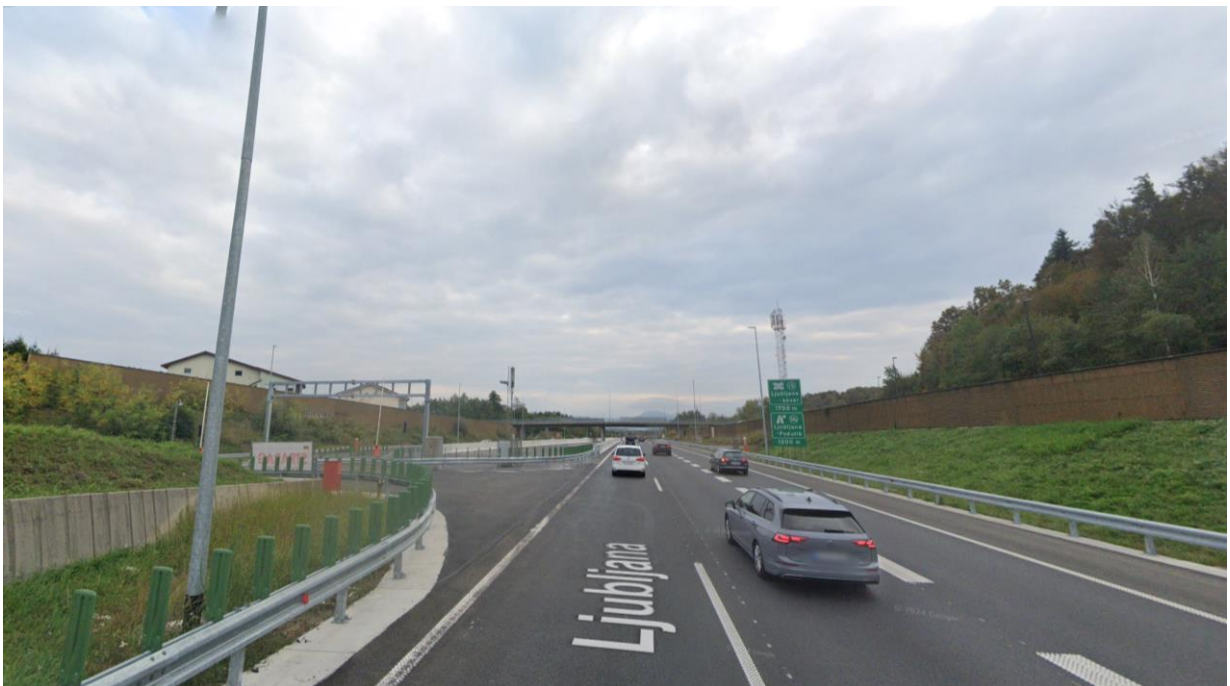
Slika 12: Pogled na mesto pojavljanja zastojev – AC-A2/0013 LJ (ŠENTVID – KOSEZE)
